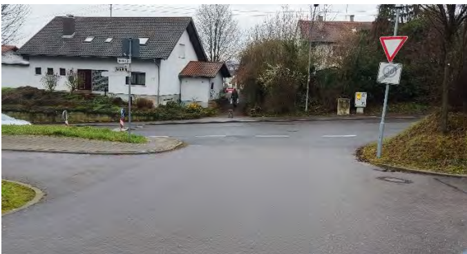
Abbildung 2.2: Erhard-Behl-Straße – Blickrichtung Süden
